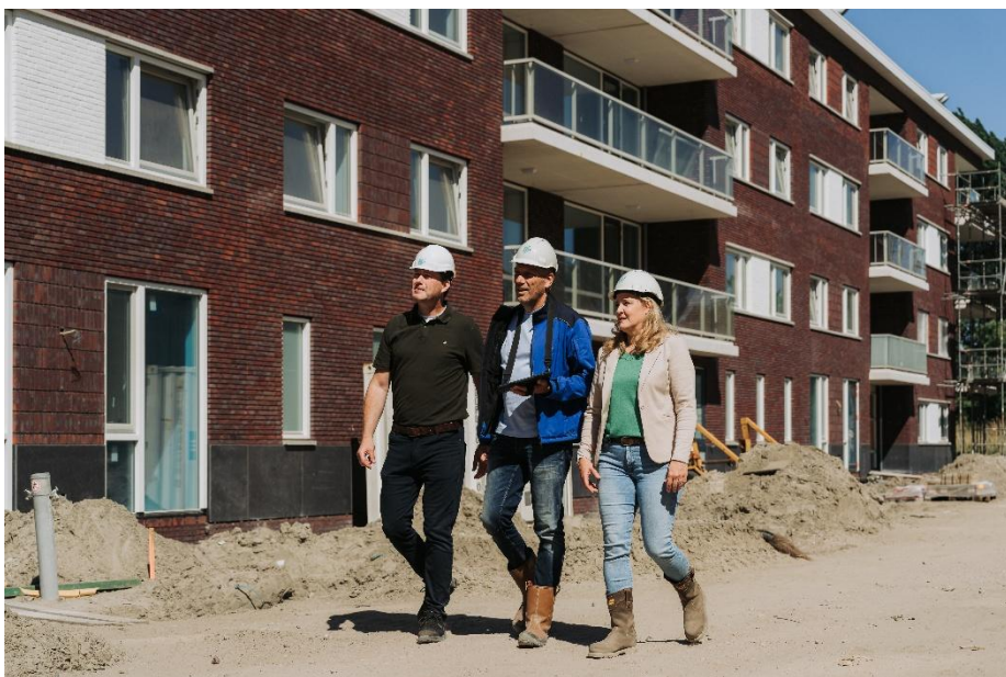
Nieuwbouw Stella Nova in Sterrenkwartier Hoog in Spijkenisse
